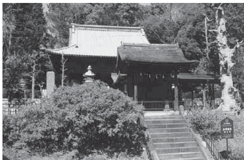
中山法華経寺【写真5】 法華堂（室町後期の建築）と四足門
