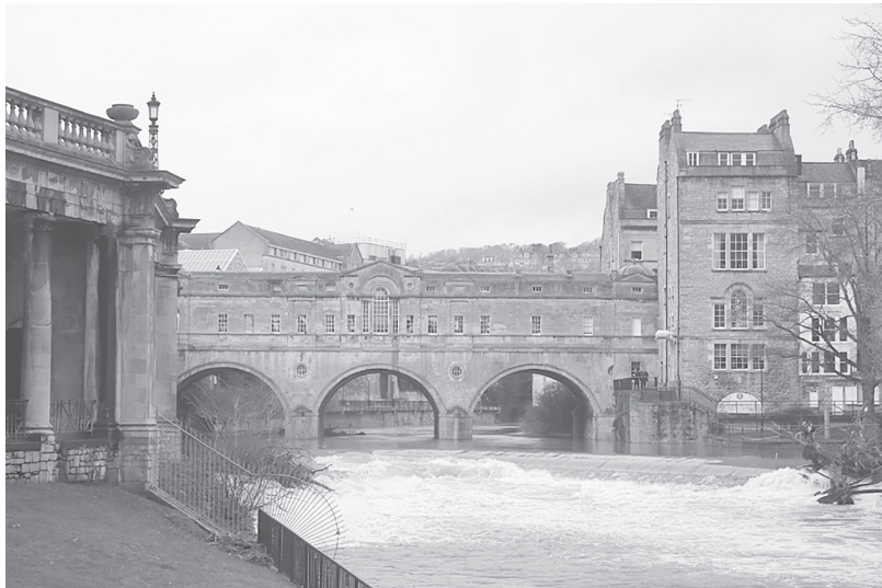
図-13 パルトニー橋 “Pulteney Bridge” (筆者撮影)
