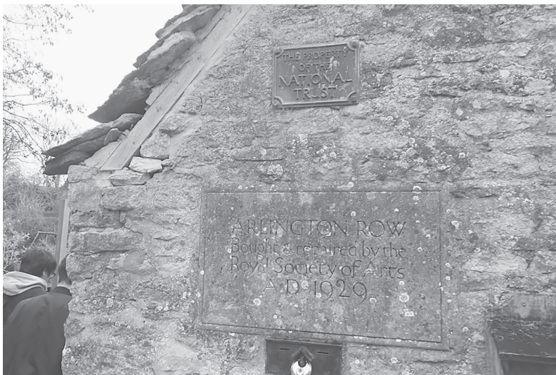
図-19 アーリントン・ロー (Arlington Row) 外壁の刻印には、“The Property of The National Trust” 「ナショナル・トラストにより管理」と書かれている。(筆者撮影)
