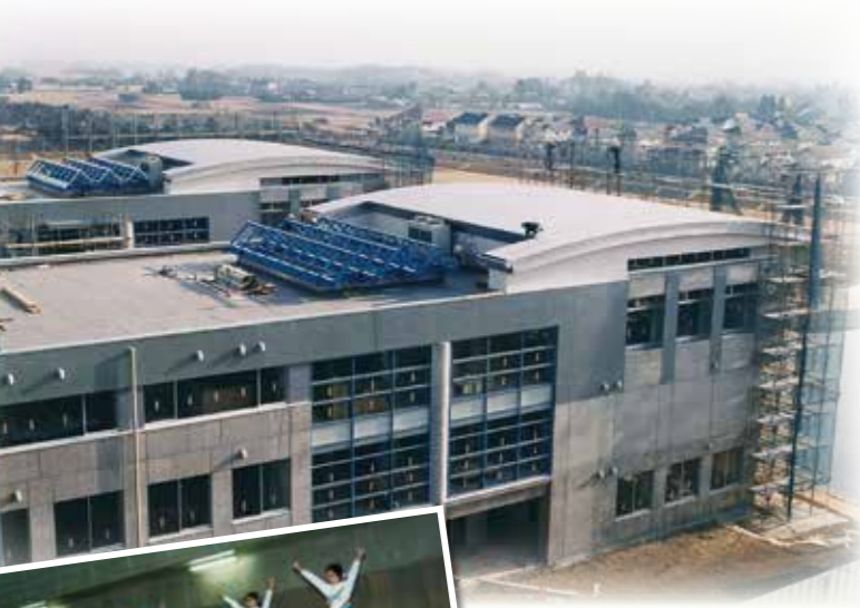
増築中の第一食堂棟
